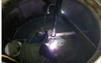
< 배관 내 용접 >
