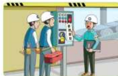
기동장치 잠금조치, 표지판 설치
