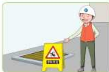
개구부 덮개 설치
