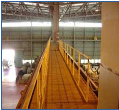
① 점검 보수통로 : 안전난간 설치
