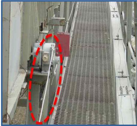
③ 컨베이어 : 비상정지장치(로프) 설치
