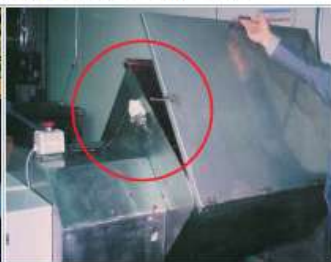
덮개 및 연동장치 설치
