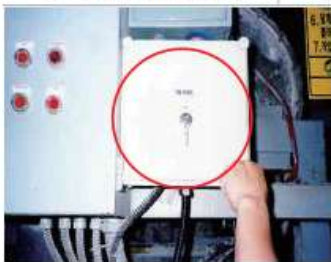
키타입 기동스위치 설치
