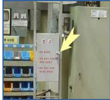
④ 크레인 점검통로 입구 잠금장치
