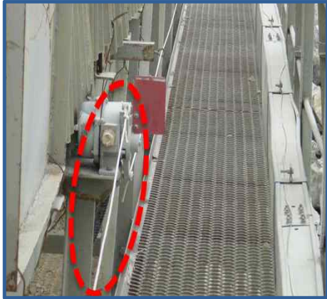
③ 컨베이어 : 비상정지장치(로프) 설치
