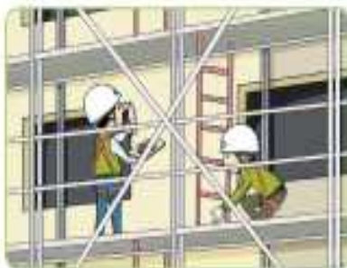
추락위험장소에 작업발판 안전난간 설치
