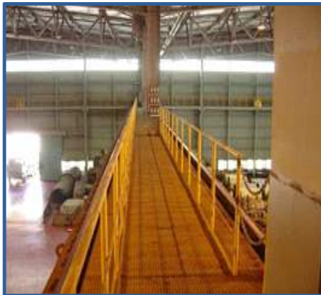
① 점검 보수통로 : 안전난간 설치
