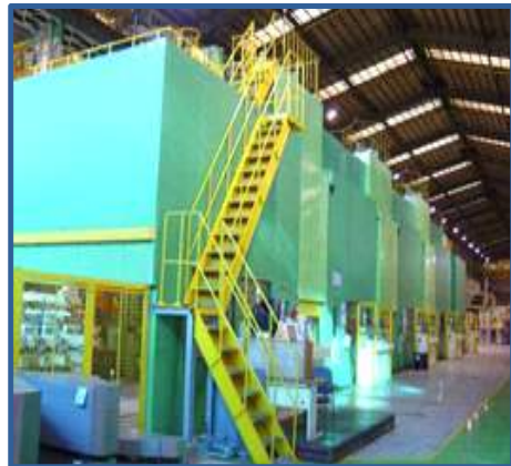
② 대형설비 상부 점검통로 안전난간 설치
