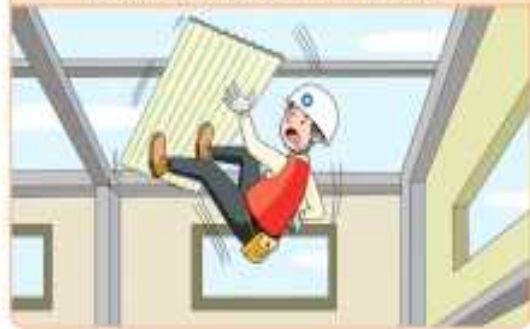
② 공장지붕 설치 중 중심을 잃고 추락
