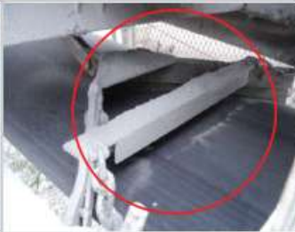
스크레이퍼* 설치 (벨트에 점착된 퇴적물 제거 장치)
