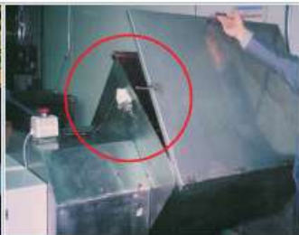
덮개 및 연동장치 설치
