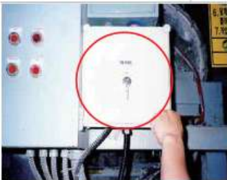
키타입 기동스위치 설치
